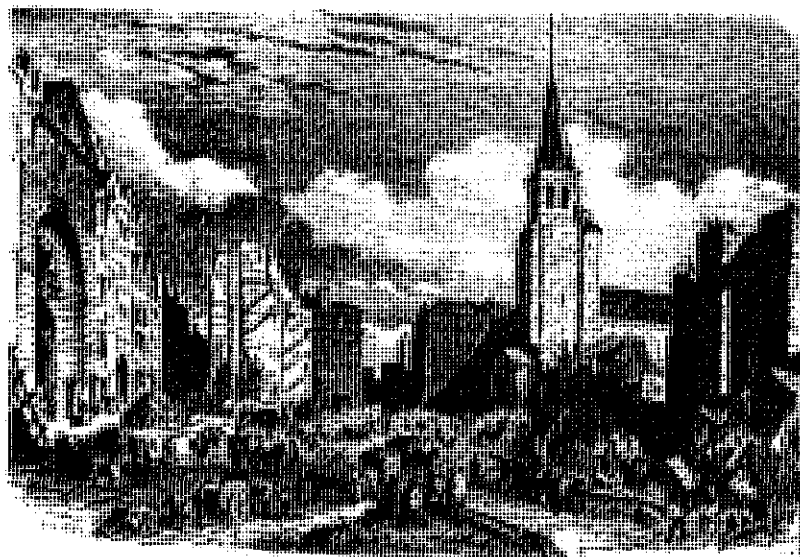
Lámina 1.3 Destrucción creadora de París en el Segundo Imperio por Haussmann: la reconstrucción de la Plaza Saint Germain.
